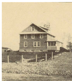
Maison pour les visiteurs à la mine Noranda, 1926
