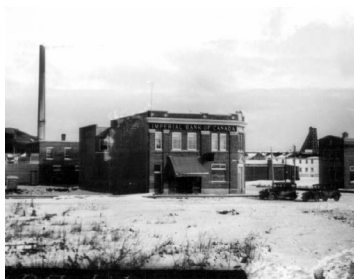
Vue de l'édifice de la Banque Impériale du Canada à Noranda, entre 1927 et 1930 Fonds Vavasour et Dick
